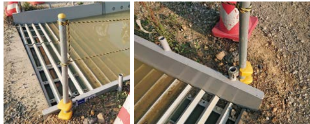
洗浄ノズルを単管パイプに固定できます
